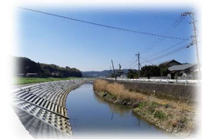
<河川の護岸工事>
