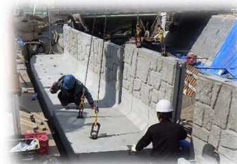
< 堤防嵩上工事の様子 >
