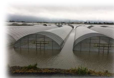
<冠水したハウス施設>
