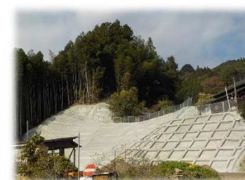
<斜面对策工事の例>
