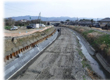
<河川の改良工事>
