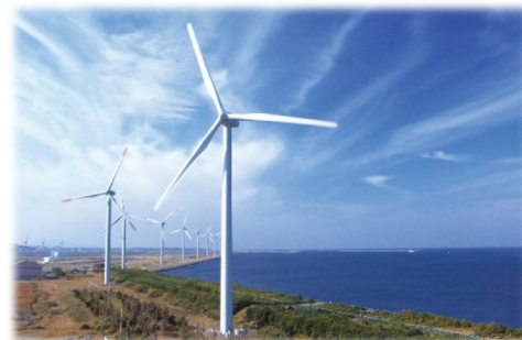
<風力発電設備>
