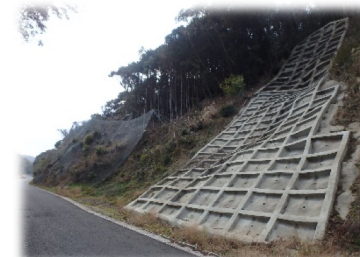
<道路法面の崩壊対策>
